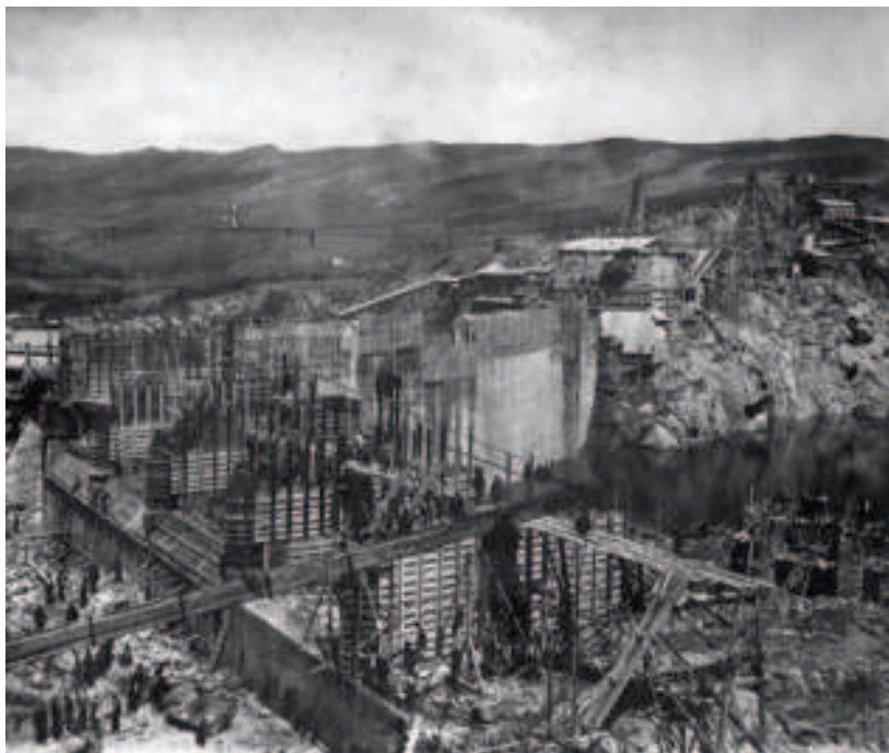
Construcció de la presa de Tàrradellas a principis de la dècada de 1910. PROCEDÈNCIA: Fons Casa Monsó.
