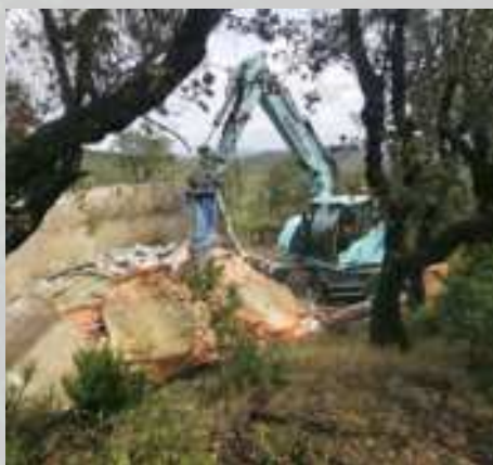
Retirada d'estructures obsoletes
