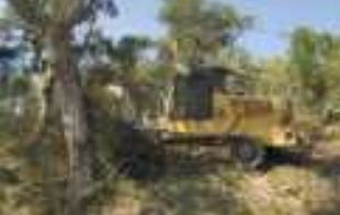
Desbrossament, tala i poda
