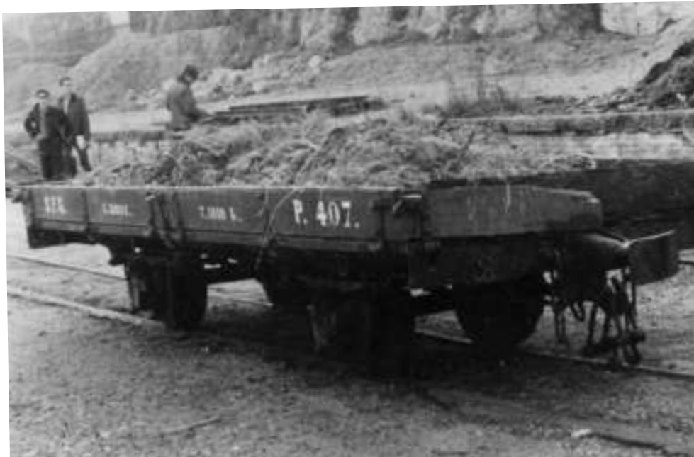
Vagó plataforma utilitzat per la brigada encarregada de netejar la via del Carrilet.
