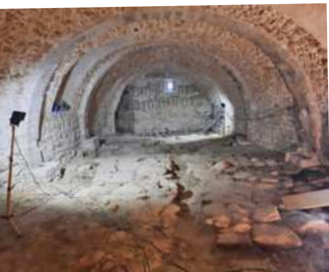
La sala 1, coneguda també com a sala museu del castell, durant els treballs d'excavació.
