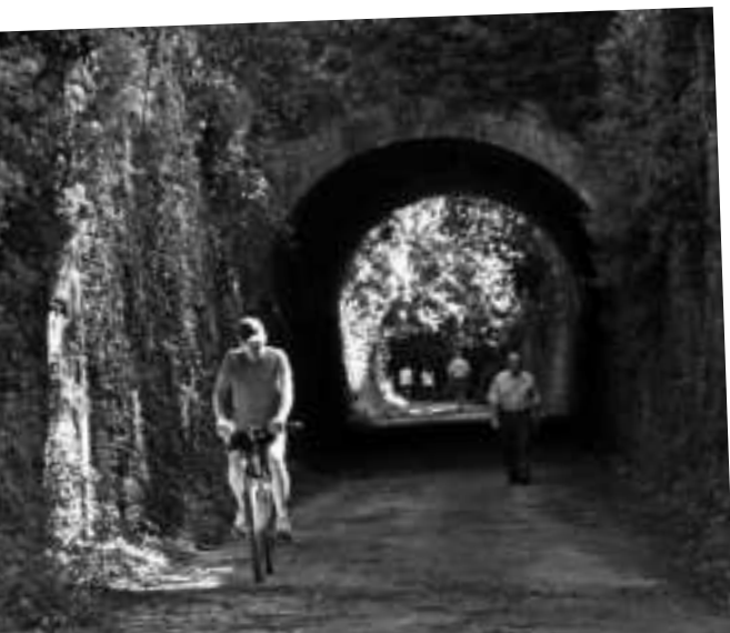
Aspecte actual del túnel de Sant Roc, al terme d'Olot.
