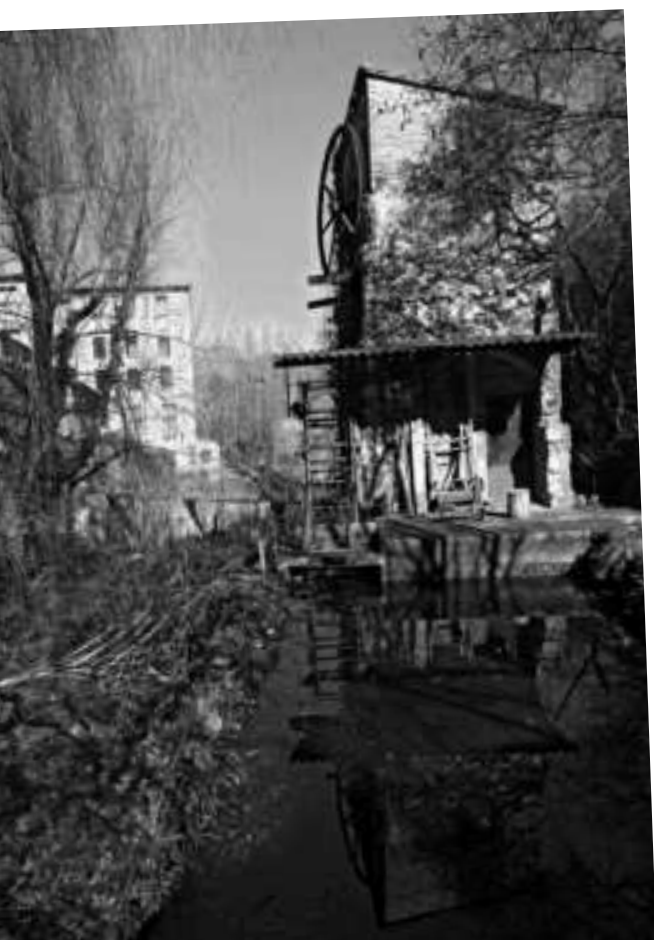
Imatge del que queda de la turbina que generava electricitat a la fàbrica de can Sabata, que es veu al fons.
