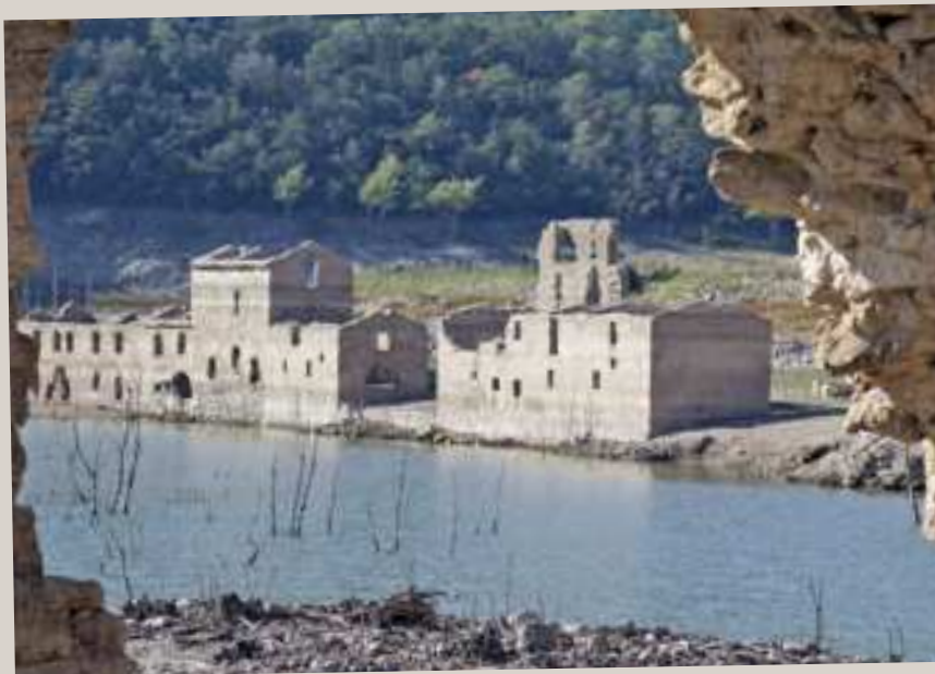
Edifici principal de la Reial Foneria de Sant Sebastià de la Muga; aquests edificis romanen habitualment submergits sota les aigües del pantà de Darnius-Boadella.
