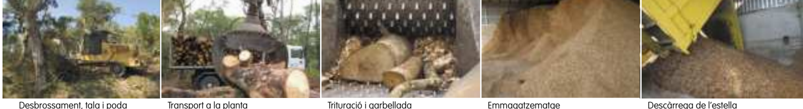
Desbrossament, tala i poda
