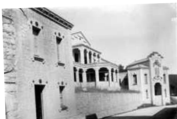
L'Asil Gomis, en una imatge de l'any 1930, en plena fase constructiva. FOTO: Arxiu Enric Tubert.
